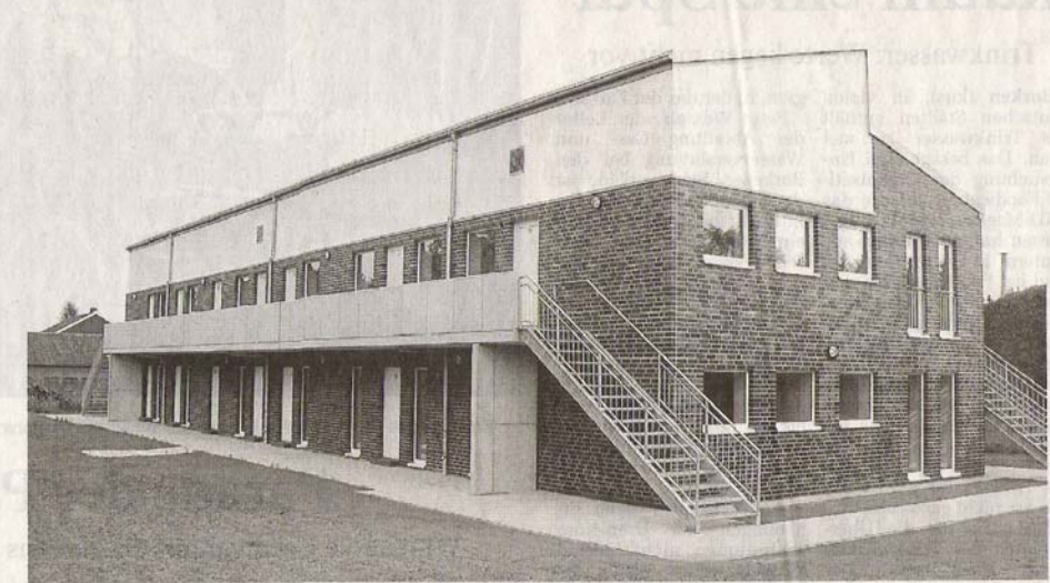
Das neue Wohnheim für Asylbewerber an der Wehrstraße in Groß Reken ist ein Passivhaus.
