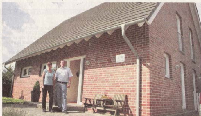
Hermann-Josef Schäfer und Helga Hilgenberg vor ihrem Passivhaus. Der Holzrahmenbau ist verklindert. Nach Norden zeigen sich solche Häuser „zugeknöpft“, große Fensterflächen öffnen sich nach Süden.
